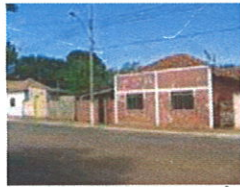
23. Residência Avenida Vinte e Três, nº 162 - Centro
