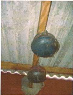
08 - Conjunto de Panca (BM) Avenida Vinte e Três, nº 162 - Centro
