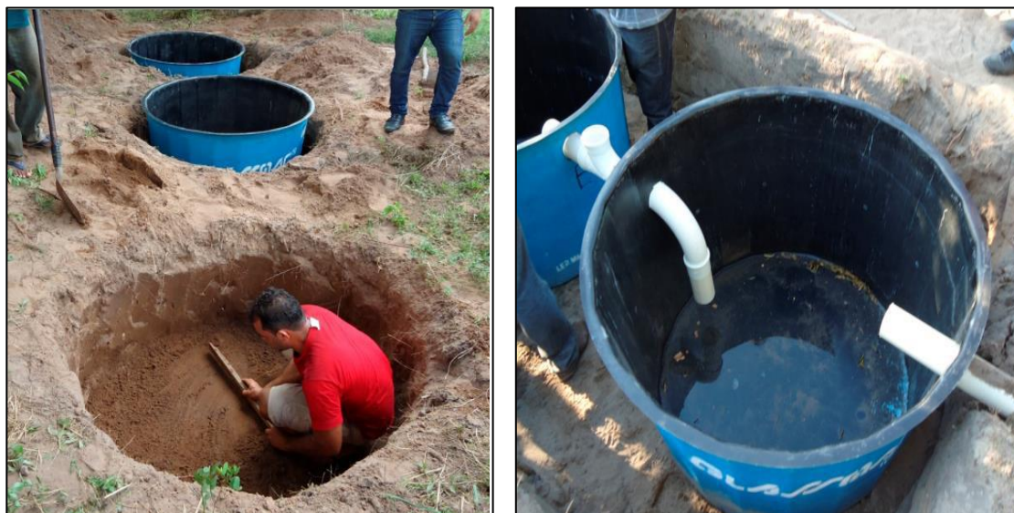
Figura 67 - Exemplo de instalação da fossa biodigestor.
