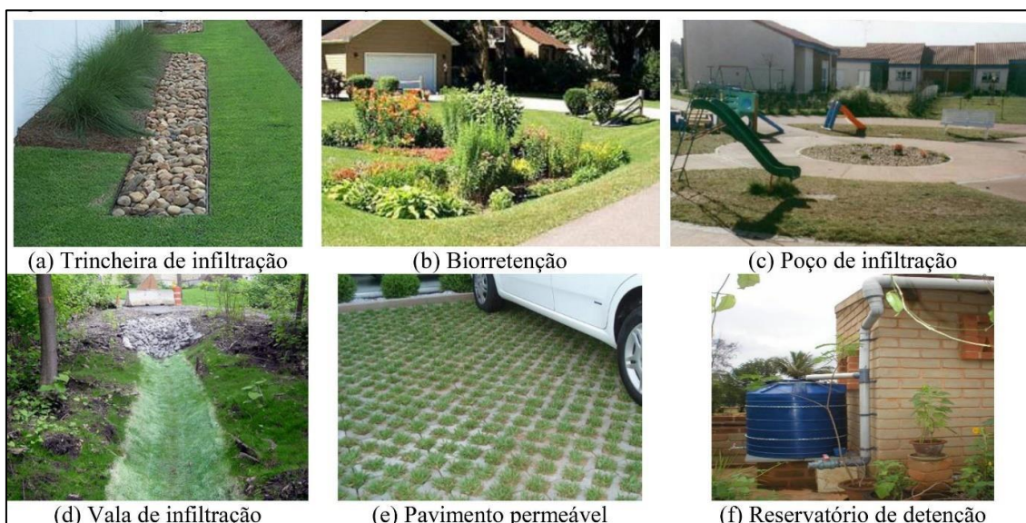
Figura 114 - Exemplos de controles na fonte.
