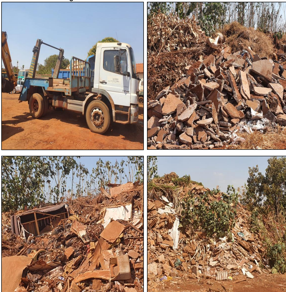
Figura 36 - Caminhão de coleta de RCC e bota-fora.
