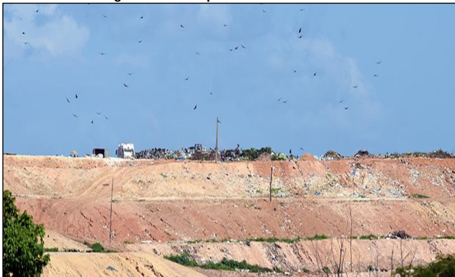
Figura 48 - Exemplo de aterro controlado.
